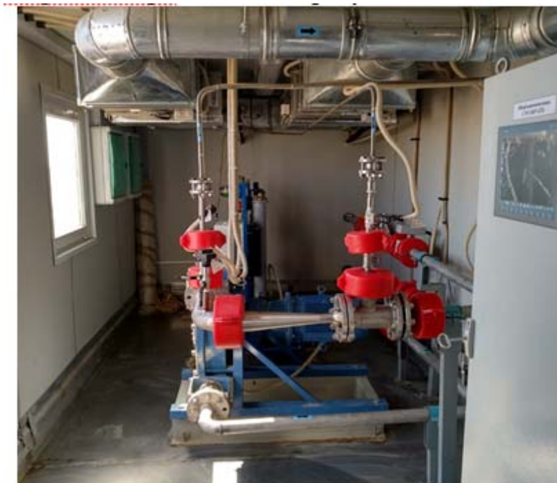
Рисунок 7 – Общий вид установленного гидроэжектора
